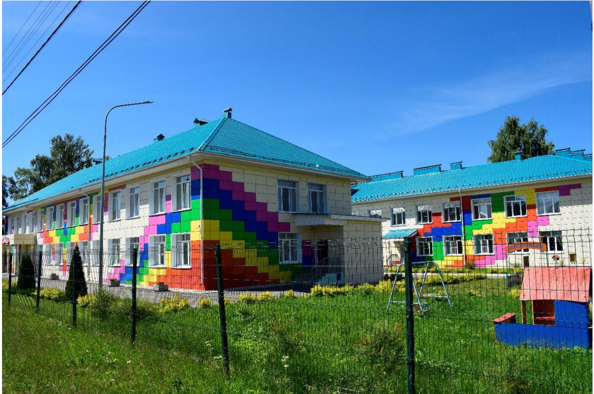
Здания южного и северного корпусов
